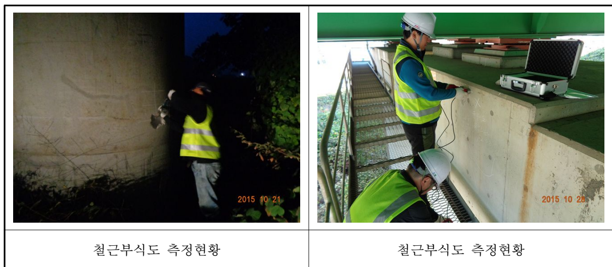
〈사진 3.25〉 철근부식도 현황
