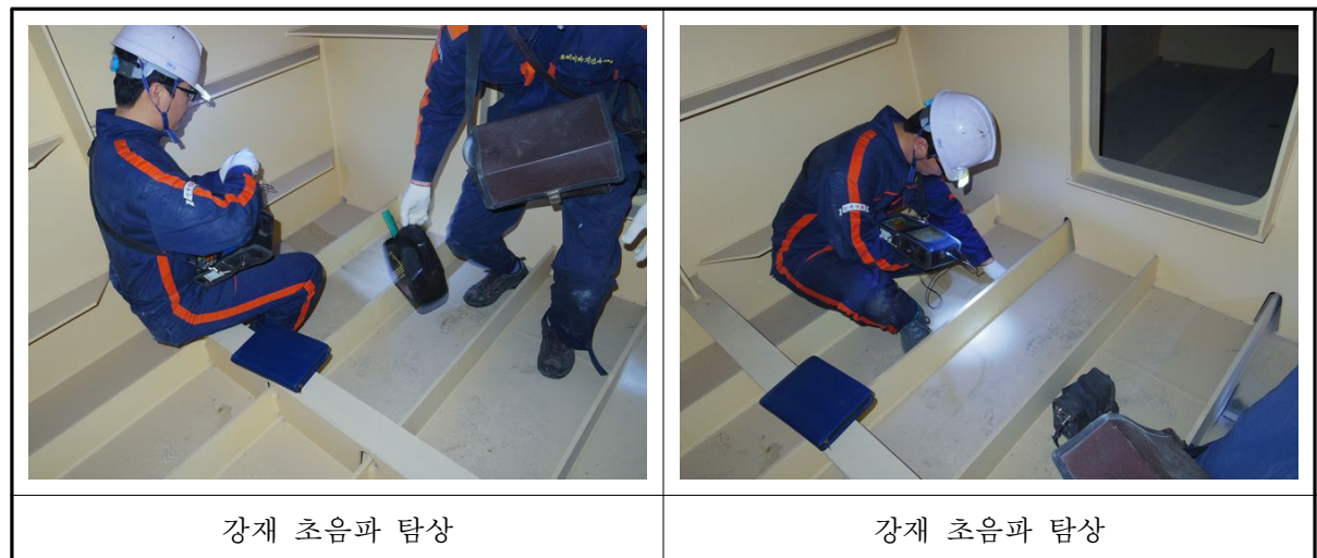
〈사진 3.26〉 강재 초음파탐상시험 현황
