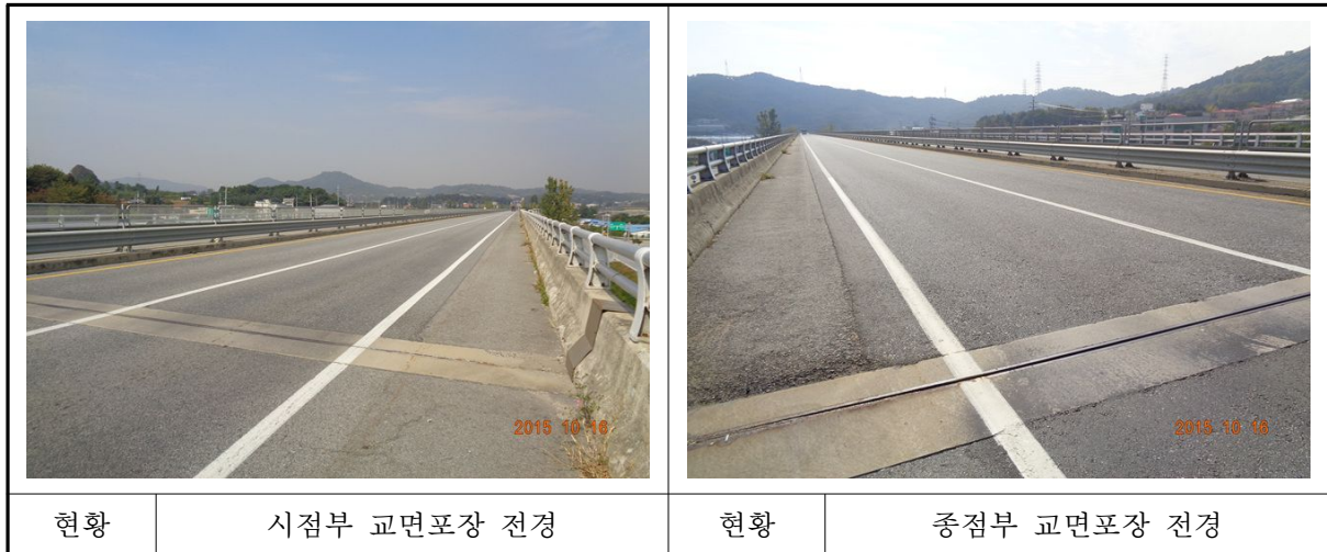
〈사진 3.2〉 교면포장 전경
