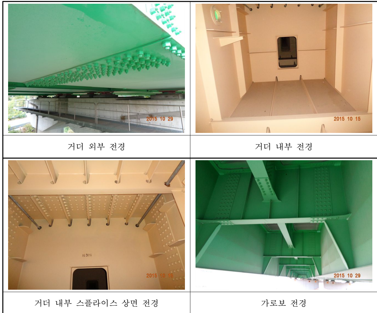
〈사진 3.12〉 거더 및 가로보 전경
