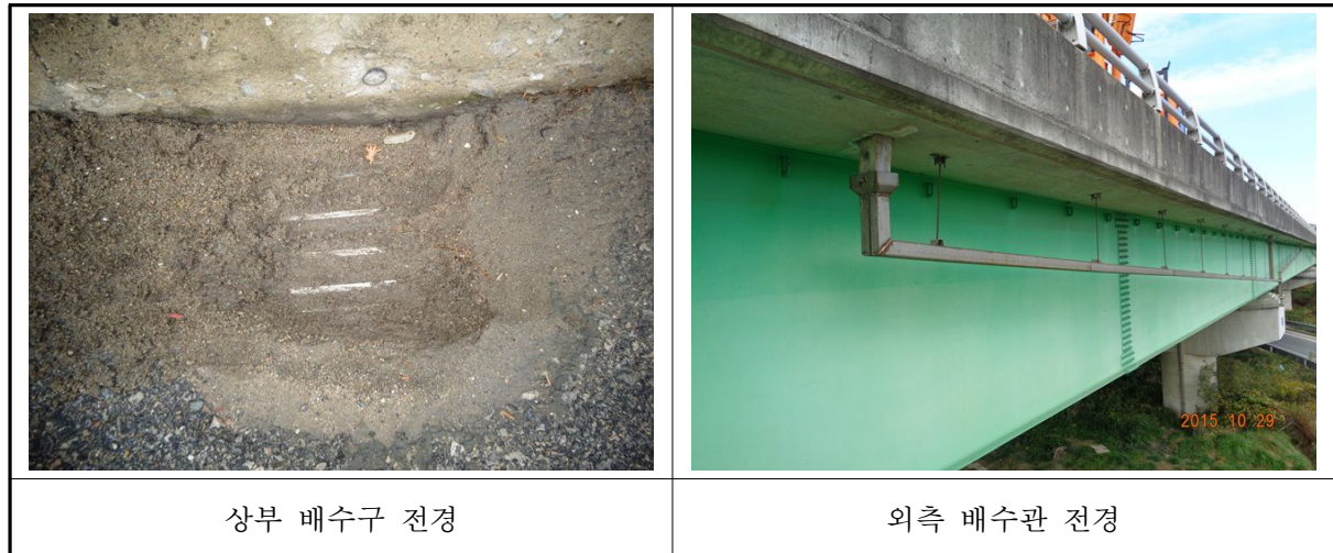
〈사진 3.6〉 배수시설 전경
