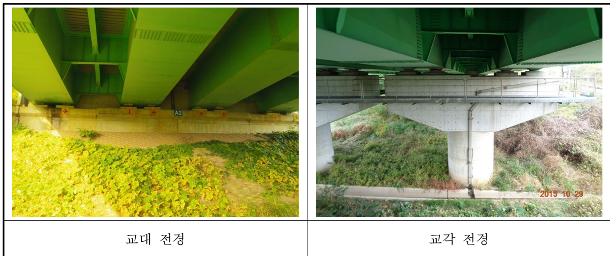
〈사진 3.16〉 교대 및 교각 전경
